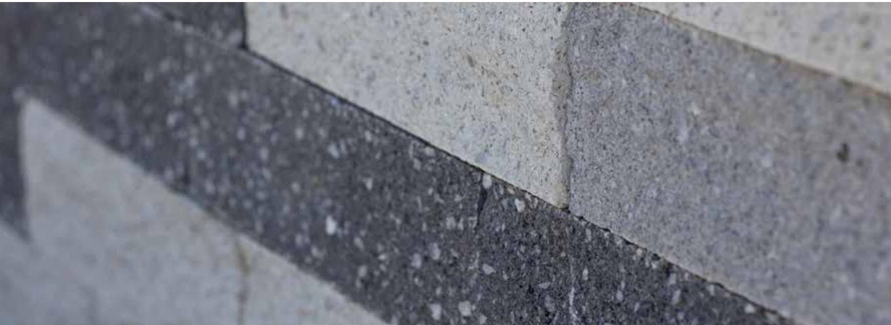
FOTO LINKS: GEMENGD VERWERKT: SPLITBLOK NOORS ANTRACIET, NOORS WIT, NOORS GRIJS. FOTO'S RECHTS V.L.N.R & V.B.N.B.: SPLITBLOK ANTRACIET, SPLITBLOK NOORS ANTRACIET .
